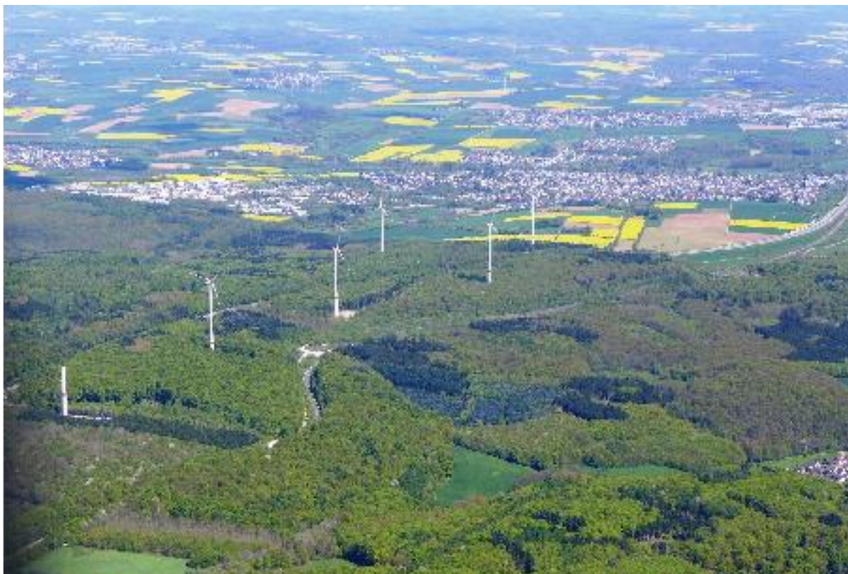
Windpark „Elzer Berg“ aus der Luft (Bild: H. Kaiser, 5/2016)
